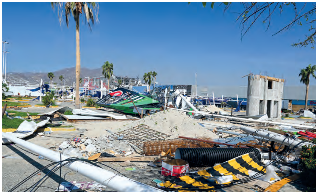
Daños del huracán Otis en el centro comercial Multiplaza Las Palmas, Puerto Marqués, Acapulco, Guerrero, octubre de 2023. Fotografía ProtoplasmaKid ©
