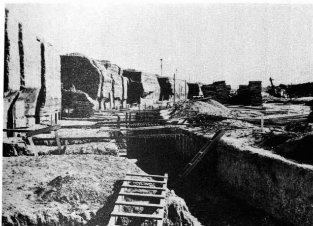
Primeros trabajos de construcción del Estadio Olímpico
