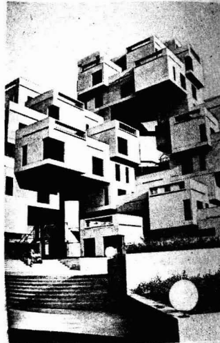
Prefabricación global como sistema constructivo
