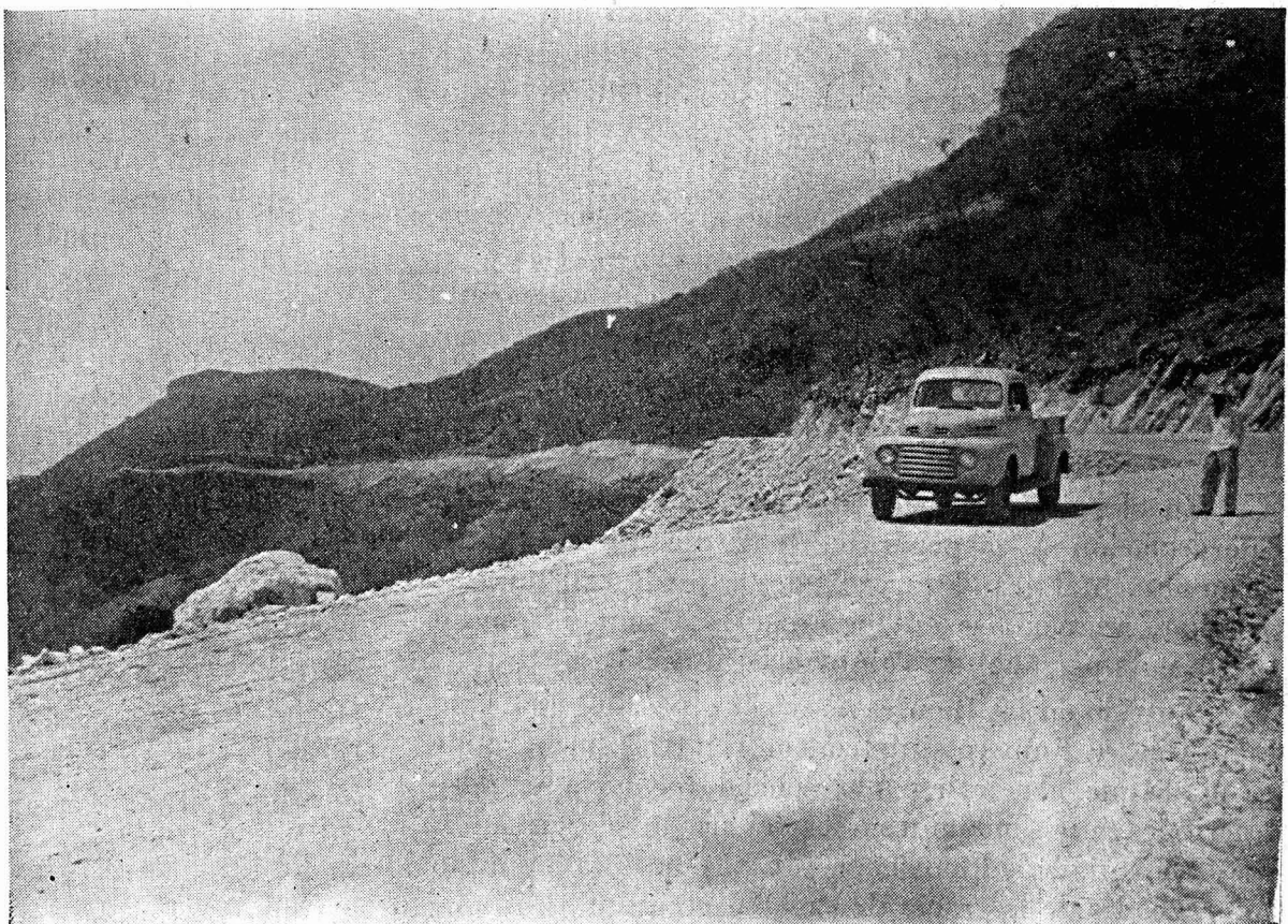
Camino vecinal Tuxtla Gutiérrez-Sumidero, Chis. Long. 22 kms. El revestimiento es una mezcla controlada por el laboratorio S. C. O. P., debidamente compactada.
