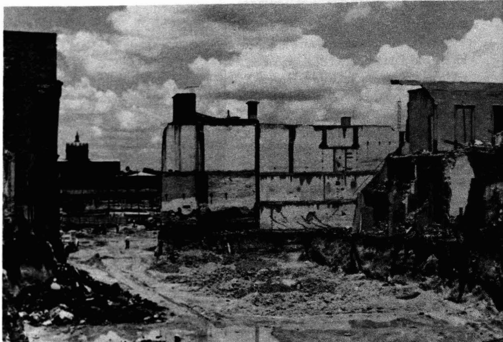
Las dramáticas y lamentables demoliciones en el curso del año de 1979
