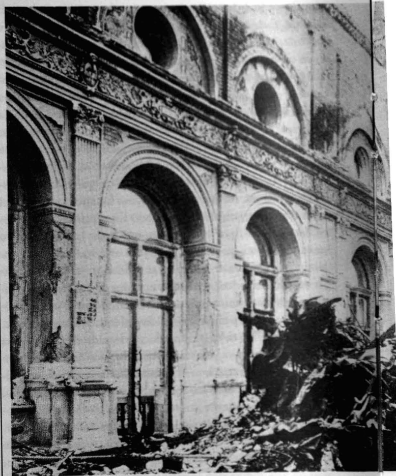
El Palacio de Justicia de Viena después de su incendio en 1927
