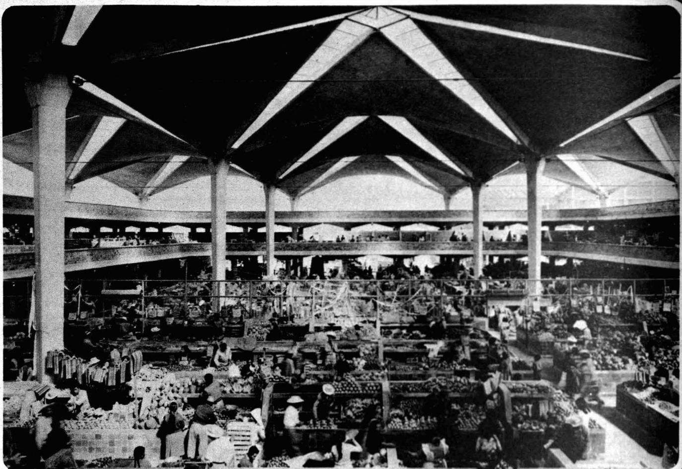
nuevas técnicas, específicamente los hongos rectos y las superficies alabeadas de concreto armado.
