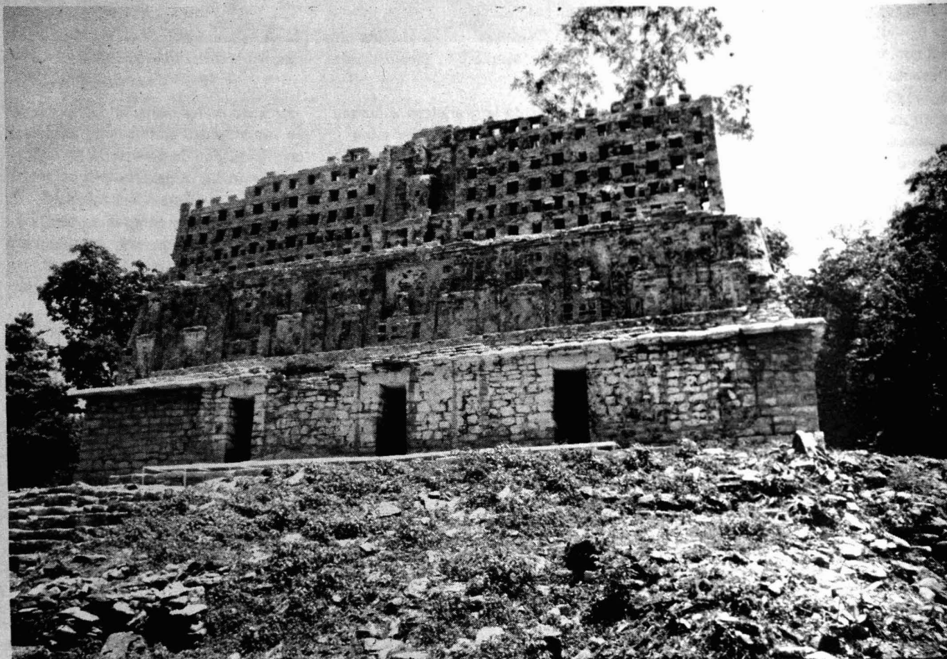
Yaxchilán Chis. Restauración del Edif. 33.1974-75
