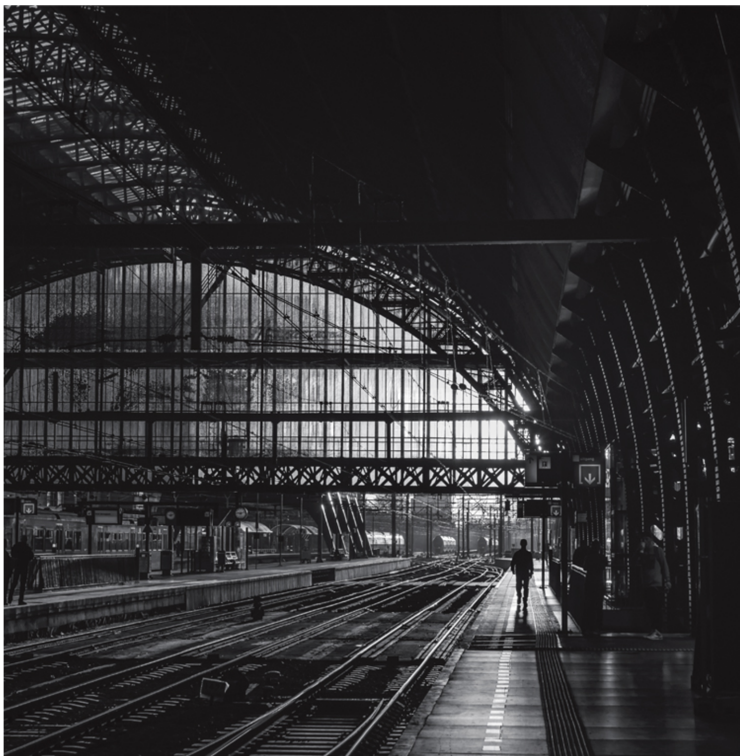
Estación ferroviaria italiana
