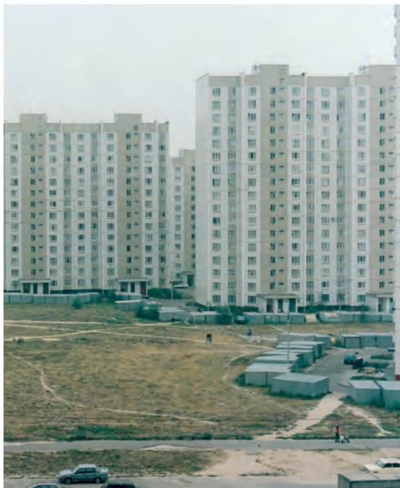
Moscú. Edificios de la calle Novokosinskaya, construidos en los años ochenta [detalle]. © Lesless / Wikimedia Commons.
