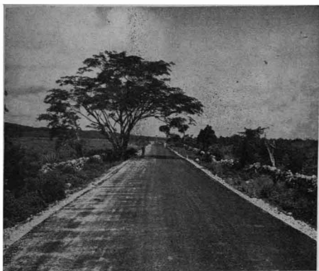
La construcción de caminos vecinales ha fomentado los campos de cultivo y multiplicado los centros de consumo, en el caso particular del camino Iruña-Cana Rosa que comunica la región agrícola del Estado de Veracruz, resolviendo el problema del monocultivo de esa Estado.
